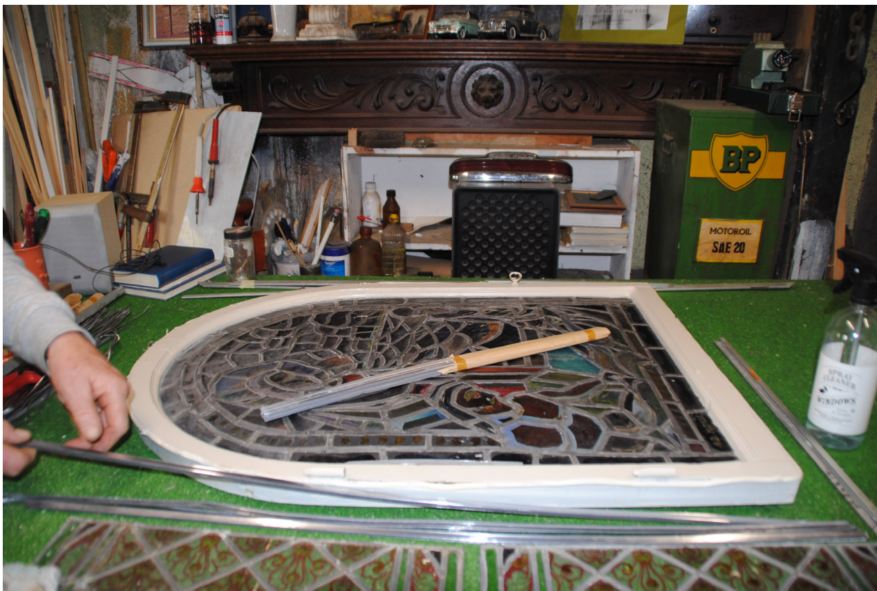
Glasfönstret i Joel Lundgrens verkstad i Hasslöv. Fönstret fick ligga plant så att den buktade formen gick tillbaka lite innan det monterades isär. Framför fönstret ses de blyspröjsar som använts för att montera ihop glasbitarna igen.
