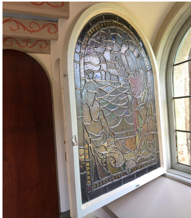
Baksidan på konstglasfönstret efter återmontering.
